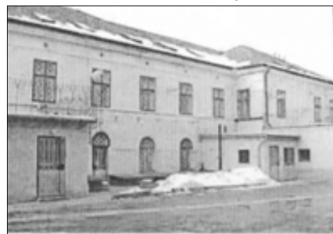
A várbörtön épülete a belső udvarból
